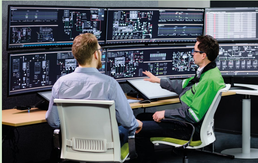
A organização da sala de controle passa a ser uma operação mais transparente. As telas aparecem de acordo com os níveis de hierarquia, começando com a visão geral.
